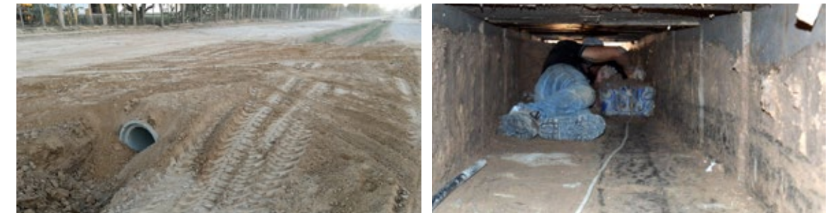
Perfilado, limpieza de alcantarillados.
