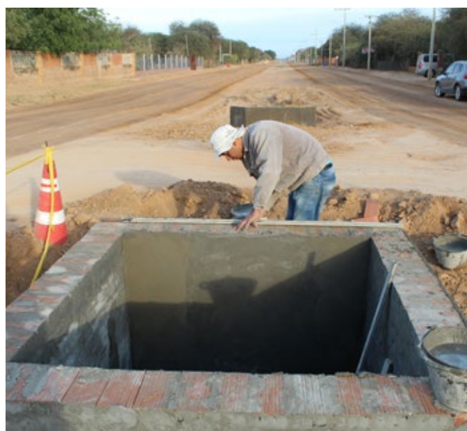
Se realizó la construcción de boca de tormenta en alcantarillado del cruce de las calles Harbiner y Chaco Boreal.
