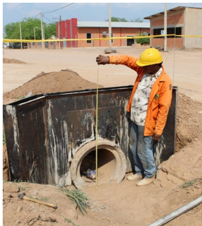
El servicio de obras trabajó en el mejoramiento de calles en diferentes puntos dentro del casco urbano de la ciudad.
