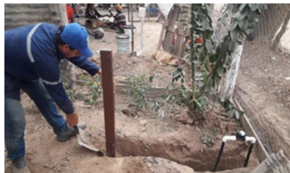
Instalación de cañerías y redes internas para provisión de agua potable al barrio de la comunidad ayorea Guida Ichai, donde viven 104 familias.
