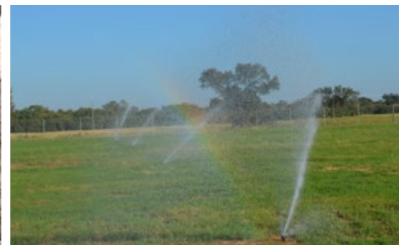
Siembra, empastado e instalación de sistema de riego en la cancha municipal.
