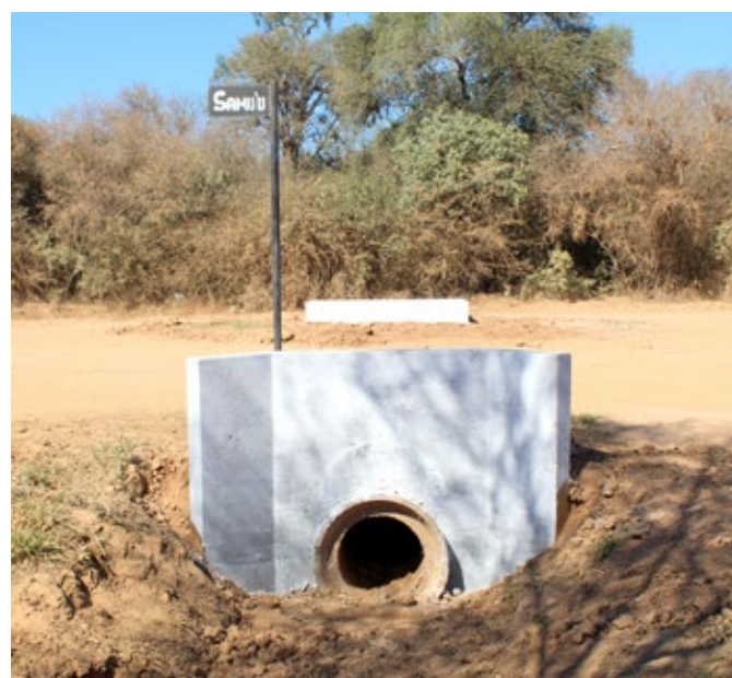
Construcción de cabecera de alcantarillas en calles del Barrio Primavera.
