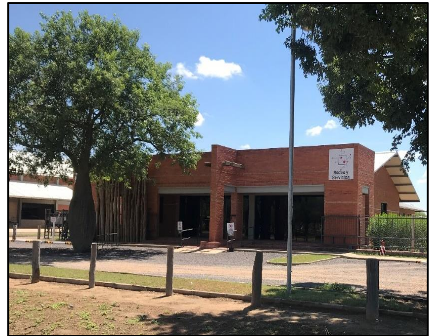
Fachada de Redes y Servicios
